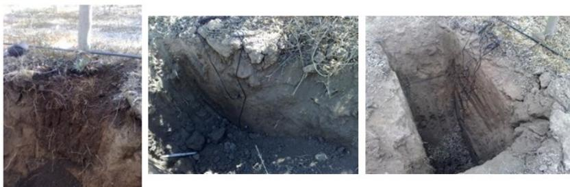
Figura 10. Secuencia de instalación de sensores FDR en terreno.
